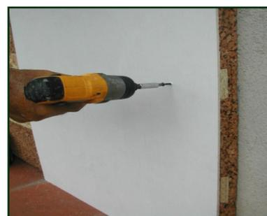
Avvitare le lastre con le apposite viti in corrispondenza ai listelli in Osb. Terminare l'operazione con la stuccatura dei giunti e la successiva finitura come una normale parete in lastre di gesso rivestito.
