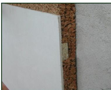
Appoggiare perfettamente a squadra le lastre Bio Pan, Cartongesso, Gesso-fibra, legno o altro direttamente sui pannelli Flex Cork, precedentemente fissati al muro.
