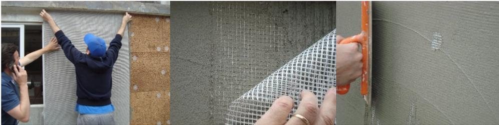
Agli angoli di porte e finestre è necessario inserire reti di armatura diagonali da applicare nell'intonaco di fondo prima dell'applicazione della rasatura armata e da fissare in modo che i bordi delle strisce si trovino direttamente sull'angolo con inclinazione di circa 45°.
